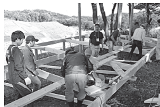
力を合わせて基礎を組み上げる
