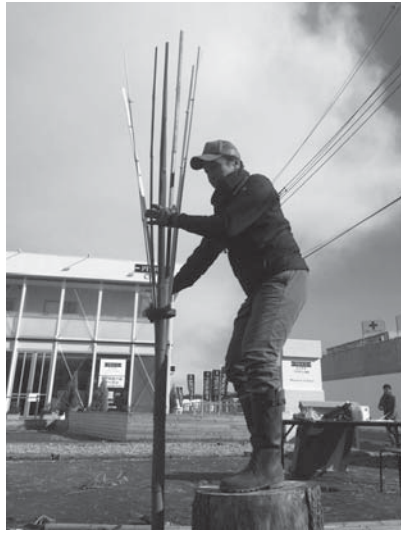
竹小舞用の真竹を、竹割器で一気に割る。まさに竹を割った様な爽快感を体験できるが本数が増えれば辛い作業に変わる。
